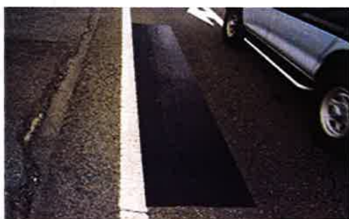
< 上：ポットホール補修 > < 左：クラック補修 >
