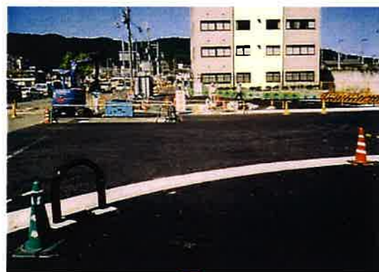
横断歩道施工
