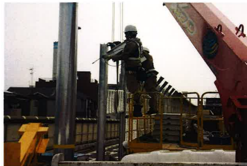
遮音壁設置工
